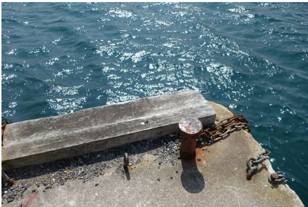
Bilde 18: Fortøyningsutstyr/kantlist/oppheng fenderverk
