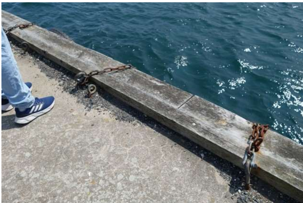
Bilde 19: Kantlist/oppheng fenderverk
